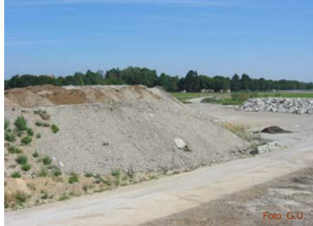
Aufgeschütteter und fast fertiger Teil der Westscholle
