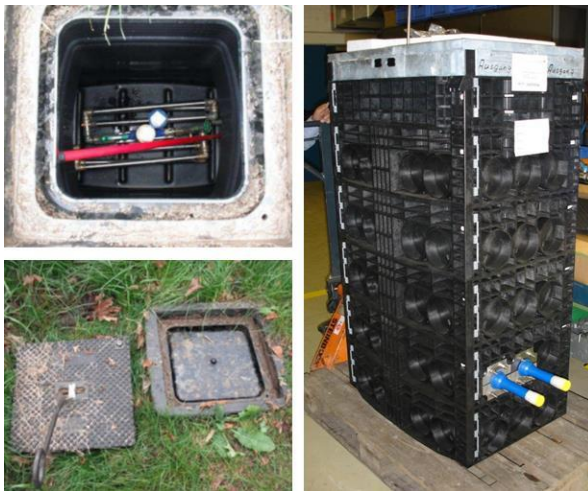
Abb. 2: Beispiel ausziehbarer bzw. nicht begehbaren Wasserzählerschacht
